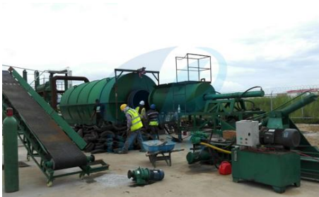
BATCH-ANLAGE WIRD MIT REIFEN BELADEN
